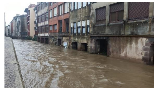
Figura 25. Inundaciones ocurridas en el invierno de 2021 en Durango. Fuente. https://dotb.eus/temporal-inundaciones-durangaldea-amorebieta-durango-otxandio/
