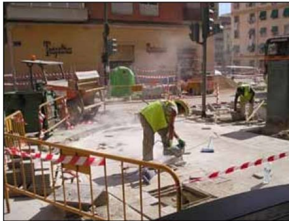
Figura 4.6. – El corte de material en seco produce una emisión alta de PM10
