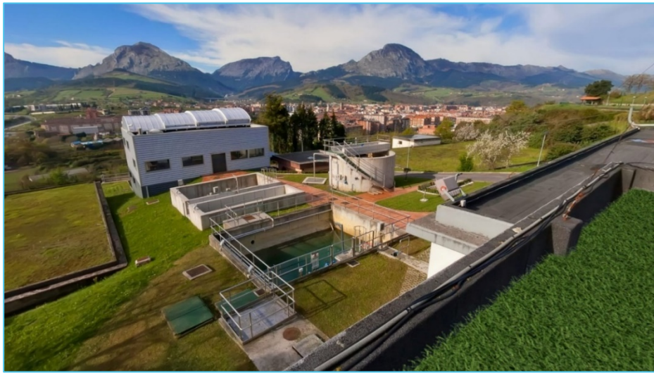
Imagen:ETAP de Garaizar. Consorcio de Aguas Bilbao Bizkaia
