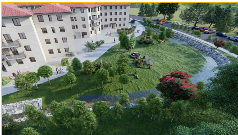
Imagen: uno de los ámbitos de intervención del proyecto de regeneración de Aramotz. Durangoko Udala.
