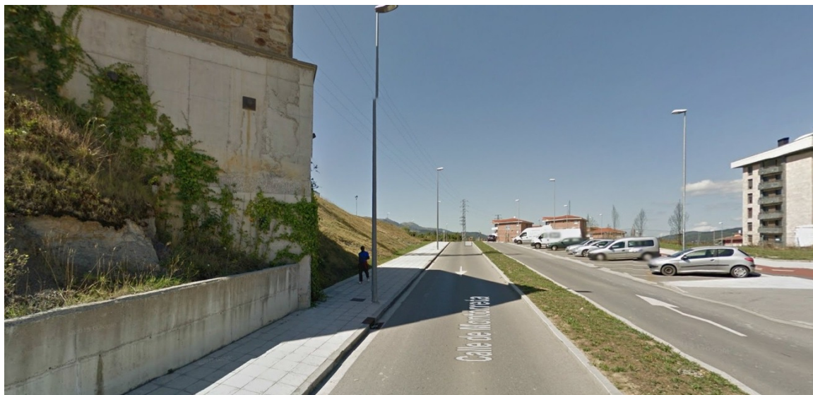
Foto 7 Vista desde la calle Montorreta hacia la rotonda existente.
