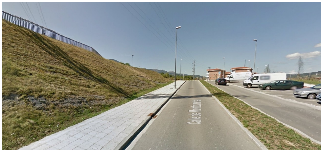
Foto 8 Vista desde la calle Montorreta hacia la rotonda existente.
