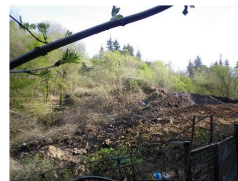
Figura 29. Deslizamiento ocurrido en el año 2013 en una de las vaguadas del barrio de Larrinagatxu (Ayuntamiento de Durango, 2013)
