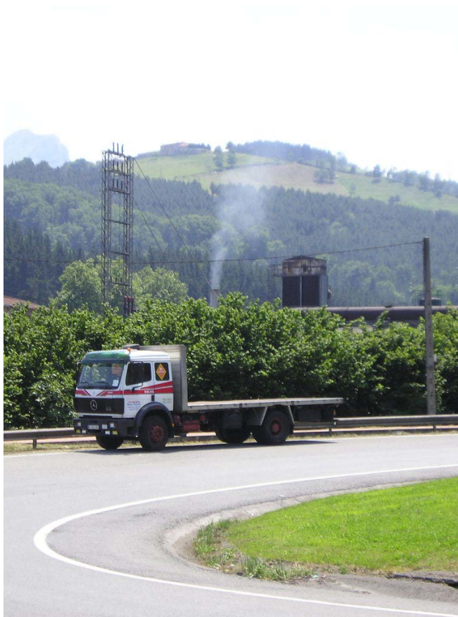
Figura A.1. – Fundifes, S.A. Situada al sur (S) del núcleo de población de Durango en la zona de Tabira
