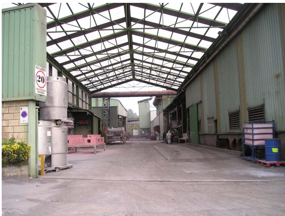
Figura A.3. – Fundiciones Fumbarri. Situada al oeste (W) del núcleo de población de Durango
