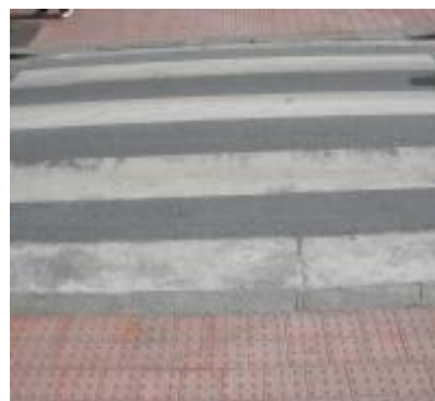
Imagen 2. Rebaje de aceras. Calle Ermodo.
